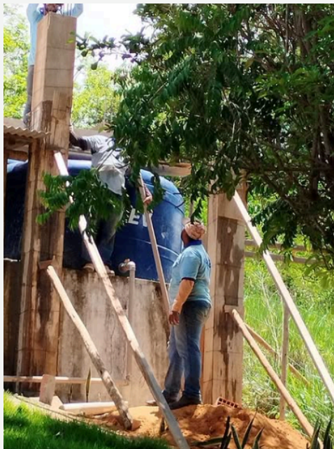
Instalação de mais um filtro para o tratamento de água em Barra da Figueira.
