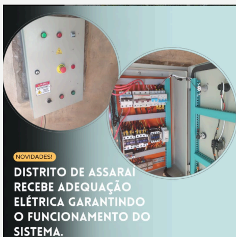
Investimento na rede elétrica no distrito de Assaraí
